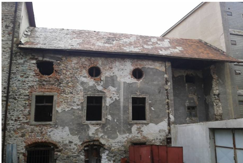
Pohľad na františkánsku baštu pred začatím rekonštrukcie, východná strana v roku 2015
