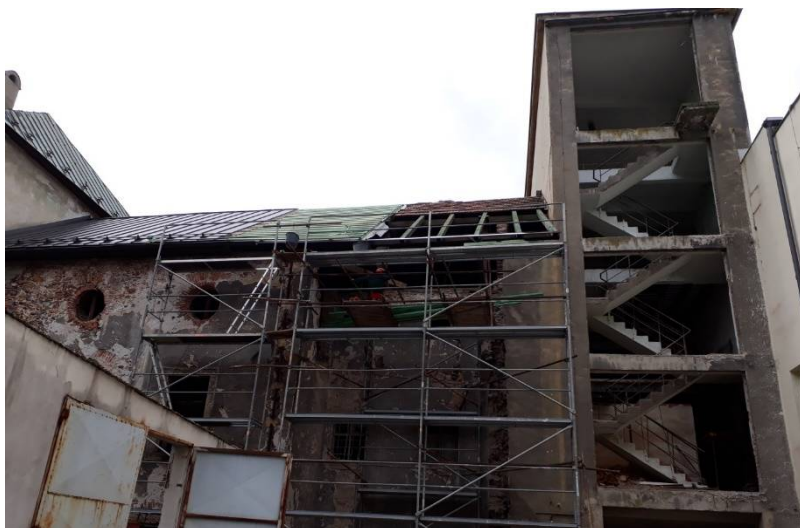
Pohľad na východnú stranu Františkánskej bašty z dvora, počas rekonštrukcie
