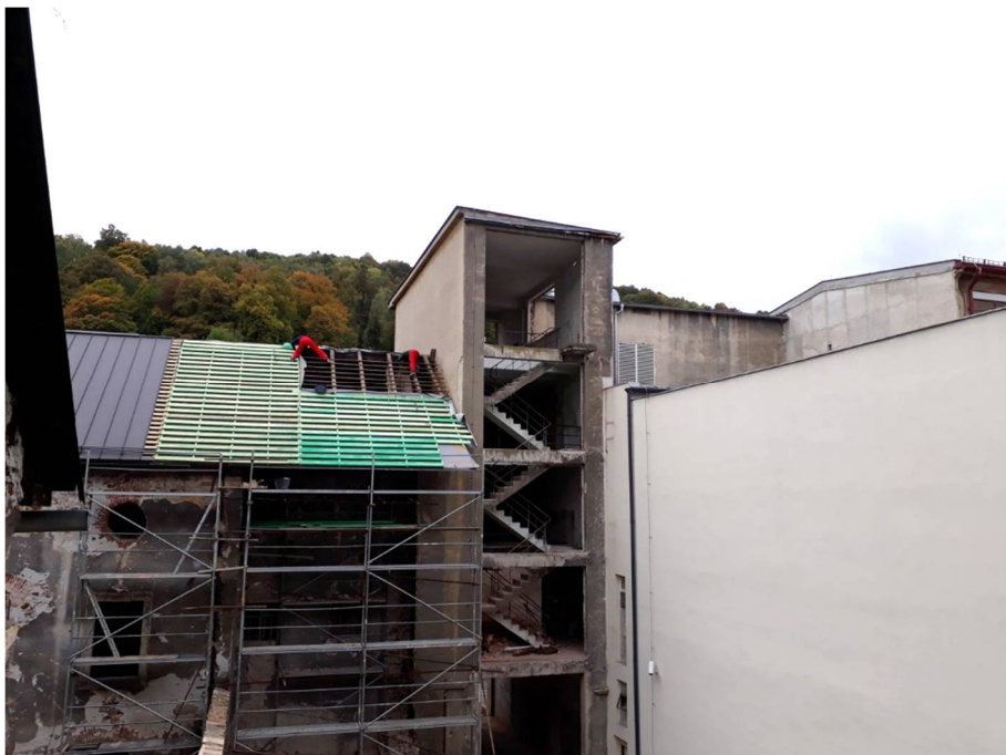
Pohľad na východnú stranu Františkánskej bašty z dvora, počas rekonštrukcie
