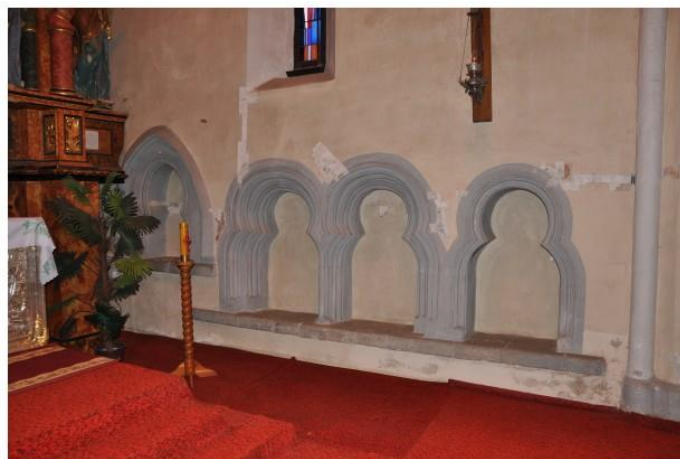
sedílie a lavabo, celok, južná stena presbytéria
