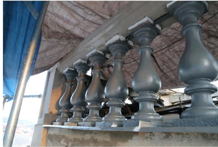
Stav v priebehu tmelenia kamennej hmoty- balustráda- detail
