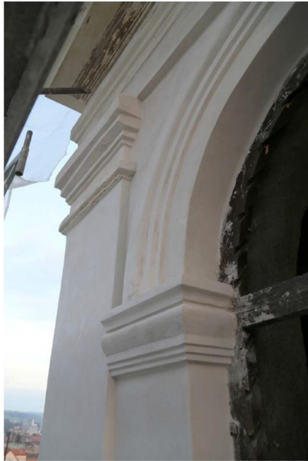
Stav po nanosení jemnozrnné štukové vrstvy- detail
